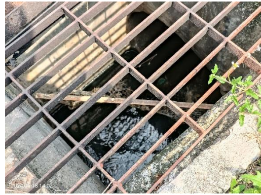
ตะกอนดักขยะภายในบ่อพักน้ำ
